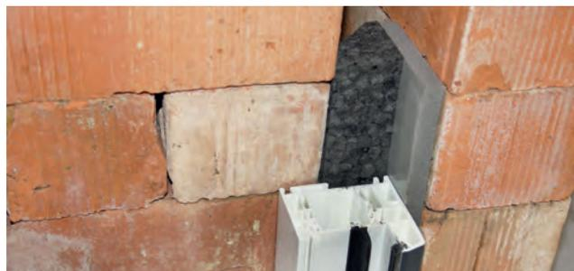
Esempio di installazione: ISO-BLOCO FILLER
