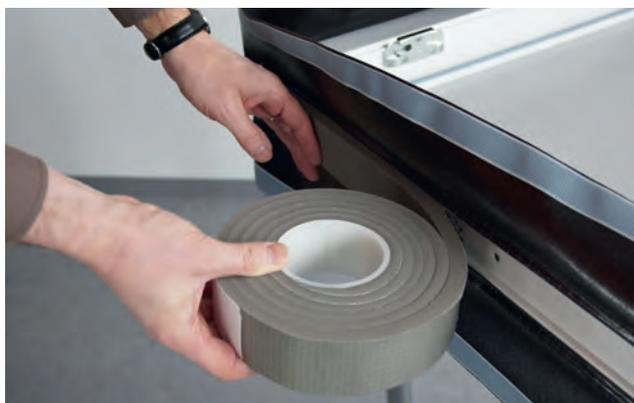
Esempio di installazione: ISO-BLOCO HF
